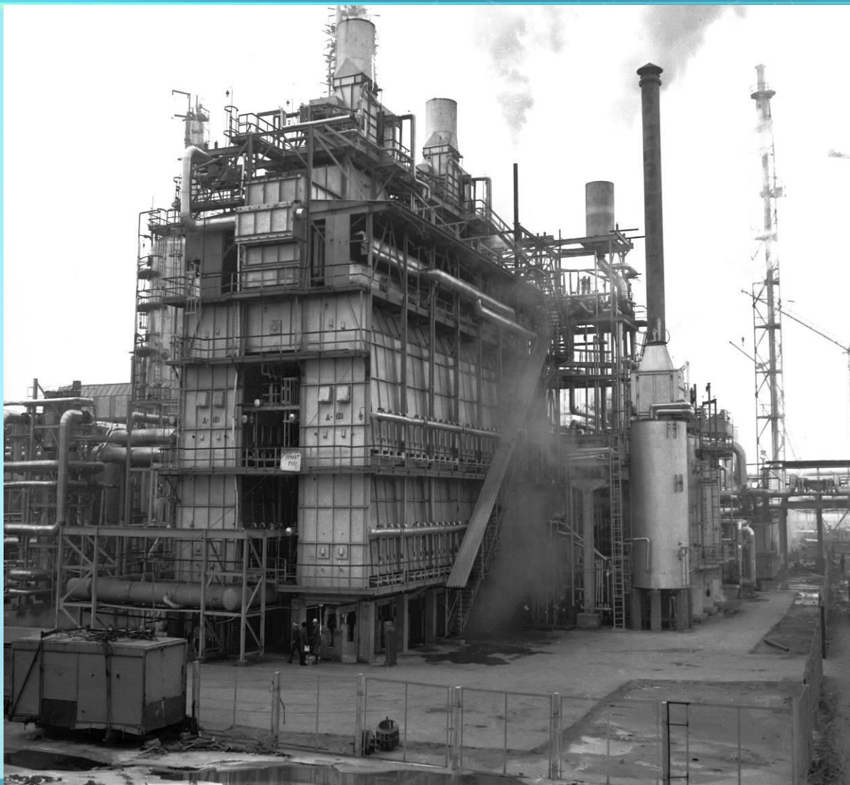
Строительство 3 блока капролактама на ТООЗе 1977-80 гг.
