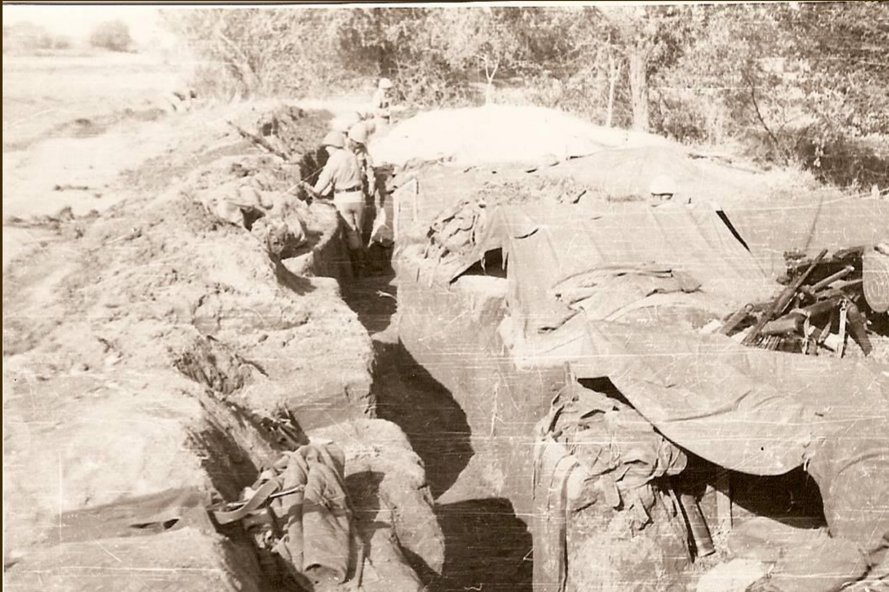
Подготовка к боевой операции. Солдаты выкапывают окопы обкладывают их камнями.
